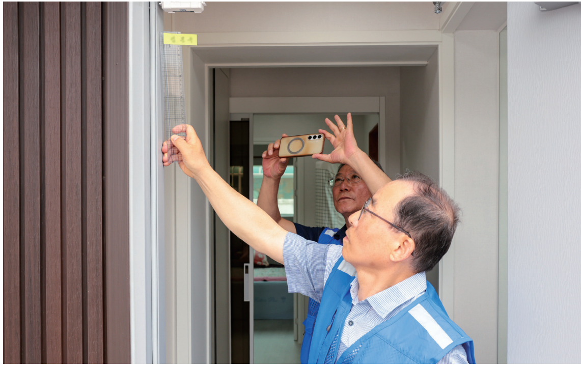
현관문 출입 감지 센서 설치를 위해 수치를 점검 중인 김돈호, 강동원 참여자
